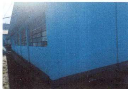
Foto 2: Pintura en muros exteriores e interiores
