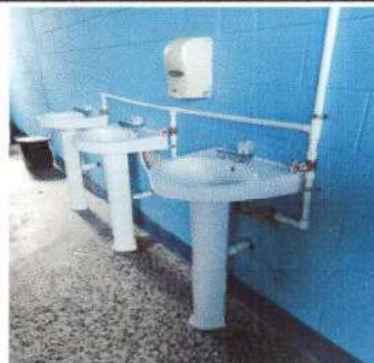
Foto 4: lavamanos sustituidos con pedestal
