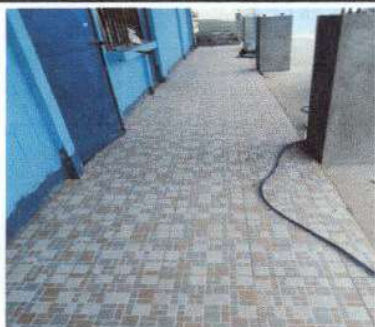
Foto 3: Piso de cerámico en corredor culminado
